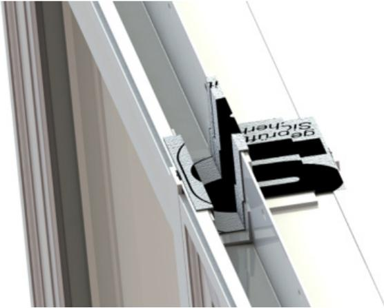
Aplica cinta impermeabilizante auto adherente sobre el borde superior de los espacios del parteluz y sobre la aleta clavada.
