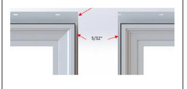
Utilizando un cuchillo de uso general, marque y elimine todo menos 5/32" de la aleta clavada de cada unidad donde la montura los conectará. Asegúrese de cortar las aletas de clavado del cabezal y del alféizar a ras de la aleta de clavado rasgada como se muestra arriba.
